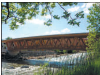
Die Brücke über die Kleine Emme ist fertiggestellt. BILD PD
